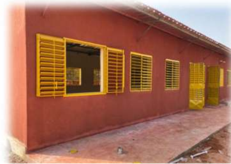
Bâtiment du lycée
